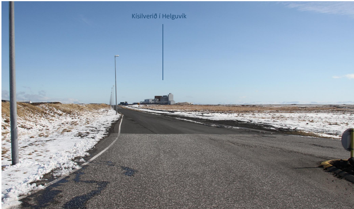
Mynd 6.1 Mynd tekin til austurs í átt að mannvirkjum kísilverksmiðjunnar í Helguvík frá mótum Garðskagavegar og Stakksbrautar vorið 2018.
